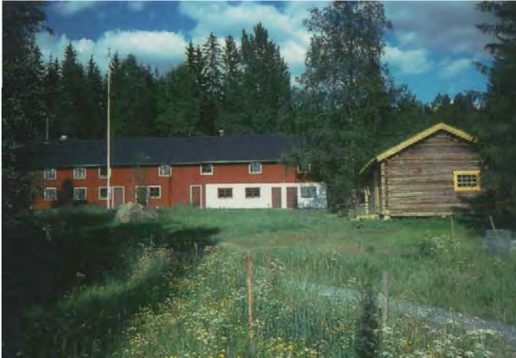
Kursgården Lertorpet. I övre våningen sovrum och samlingsrum. Den vita nedre delen, fd ladugården, är nu matsal. Längre till vänster föreläsningssal och administrationsrum. Ladan till höger lär vara från slutet av 1600-talet (foto Leif Engh).
