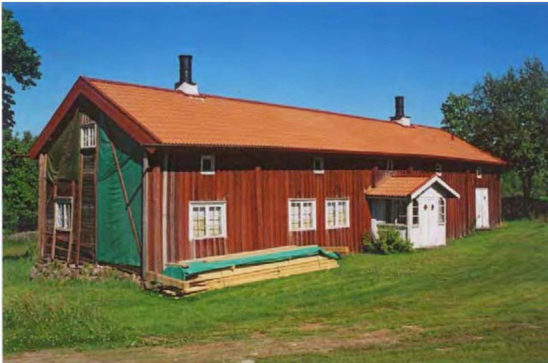
Bergsmansgården Kärn cirka 5 km norr om Bosjöns herrgård fotograferad i juni 2005. Som syns har taket fått nya tegelpannor och kortväggen mot söder skall få nya foderbräder. De fina takmålningarna i storstugan fascinerade Berith som gjorde en miniatyr av detta rum som nu finns på Värmlands museum. (foto 2005 Ingmar Bergström).
